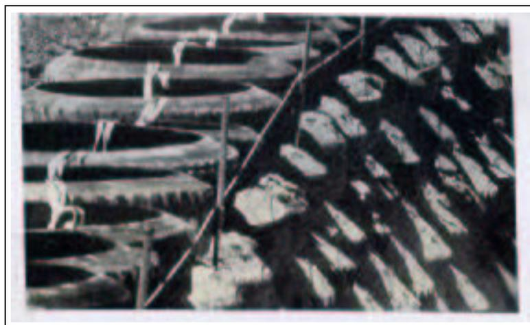
FIG. 1.4 – Un parement en Pneusol
