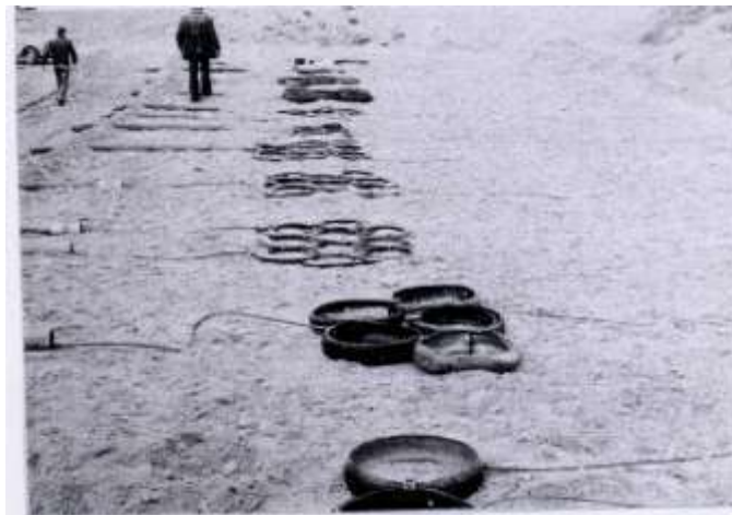
Figure 24 : Assemblage de pneumatiques en nappes
