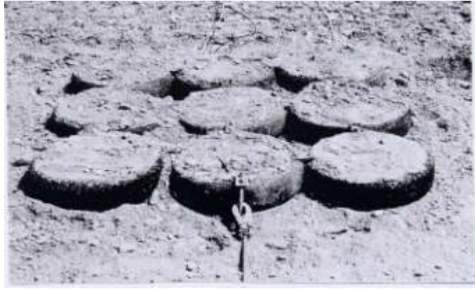
Figure 26 : Bandes de roulement sur chant en nappes (trame carrée). Vue avant remblaiement
