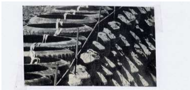
Figure 4 : Un parement en Pneusol
