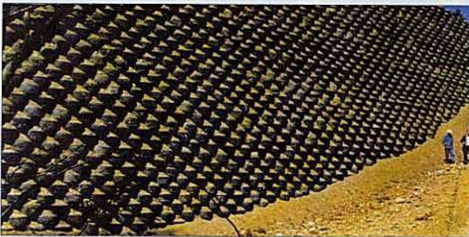
Mur de soutènement en PneuSol
