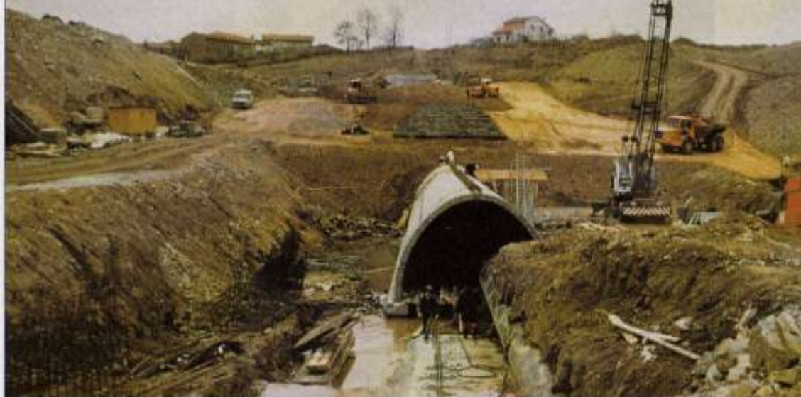
Fig. 3 - PneuSol répartiteur de contraintes ou anti-Marston
