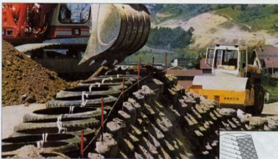
Ouvrage en Pneusol utilisant des pneus poids-lourd
