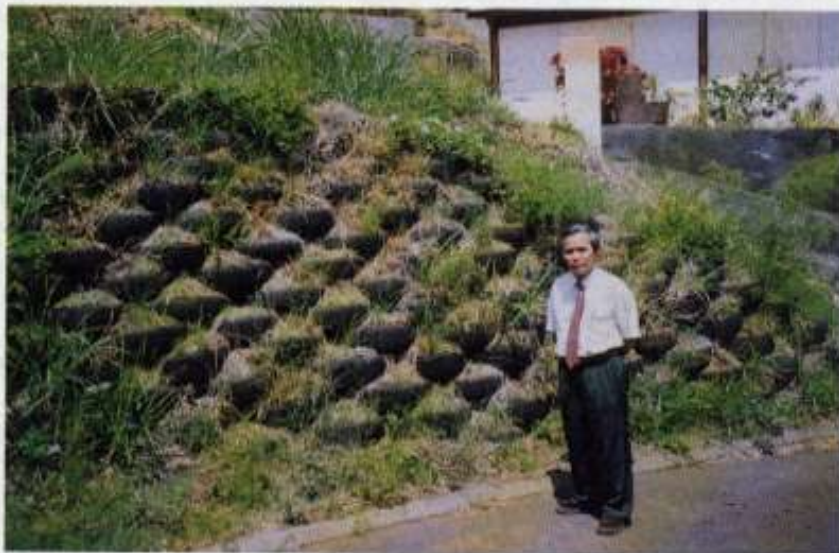
Mur de soutènement à l'Étang Salé (Lotissement «Les Vivanguis») - Réalisation Expérimentale
