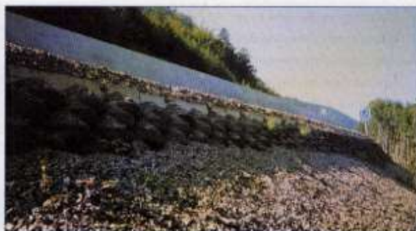
Fig. 1 - Ouvrage en Pneusol
