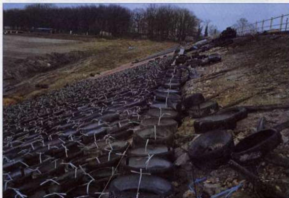
Fig. 5 - Pneusol protection des pentes et des berges
